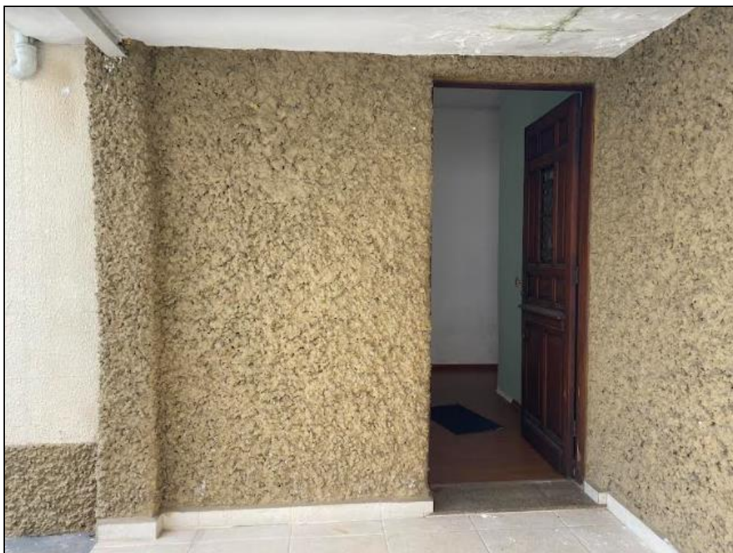
FOTO 23 – DETALHE REVESTIMENTO CHAPISCADO RUSTICO PARA PROTEÇÃO PAREDE .
