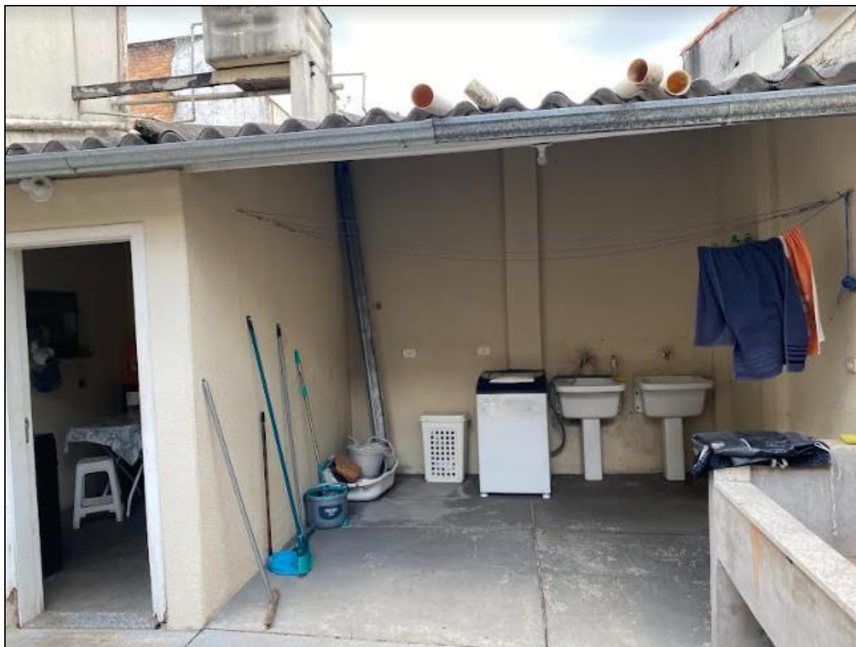
FOTO 37 – COBERTURA SIMPLES E ÁREA SERVIÇO.
