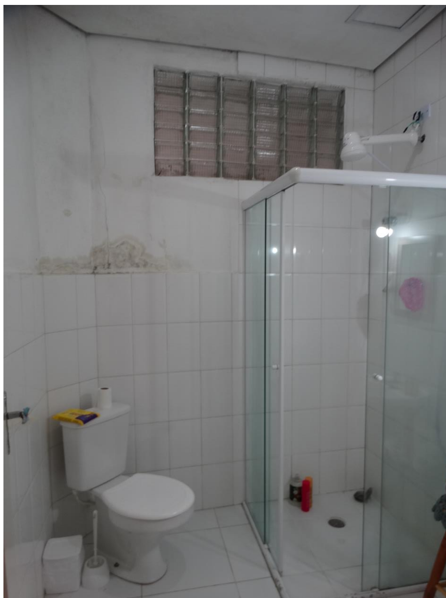
FOTO 35 – INSTALAÇÕES DO BANHEIRO SOCIAL.
