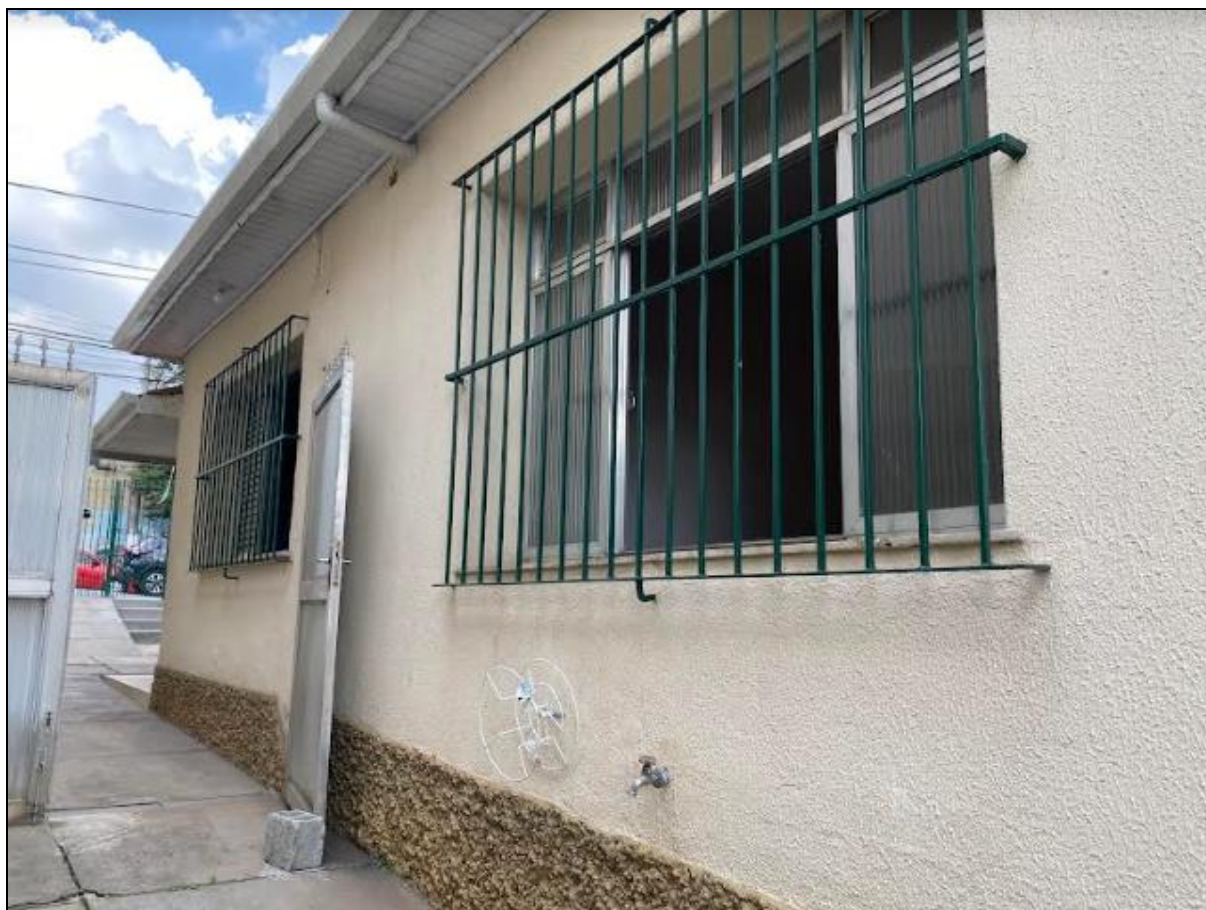
FOTO 24 – ASPECTO DA PINTURA EM LATEX E GRADES DE FERRO.
