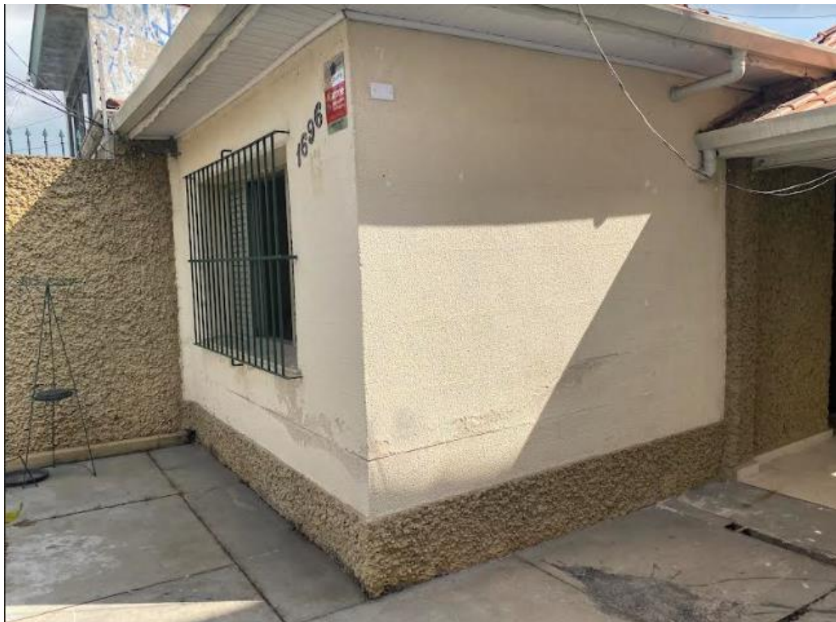
FOTO 21 – ASPECTO CARACTERISTICAS ORIGINAIS.
