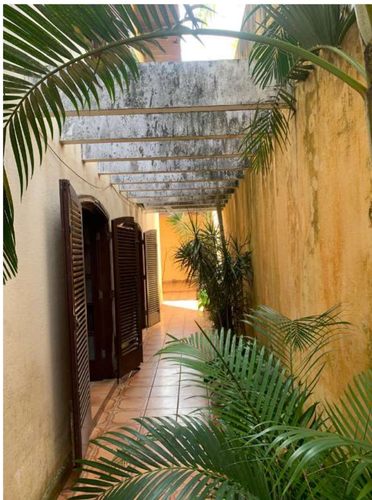
Foto nº. 6 – Vista do recuo lateral do imóvel avaliado de quem da frente olha para os fundos.
