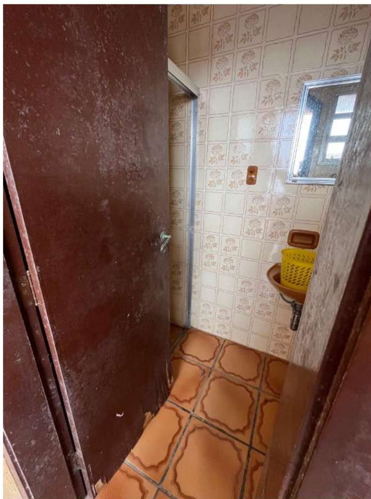
Foto nº. 24 – Vista parcial do banheiro de serviço.
