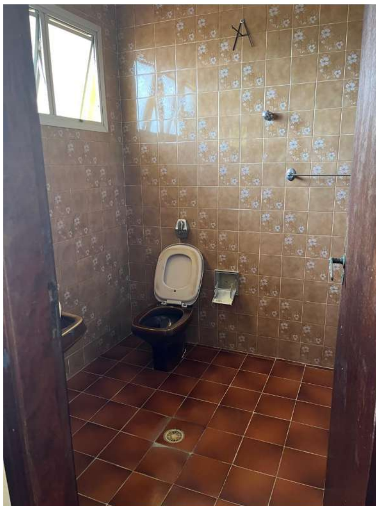
Foto nº. 30 – Vista do banheiro 1.
