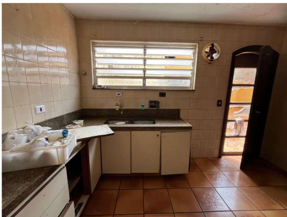
Foto nº. 17 – Outra vista da cozinha do imóvel.
