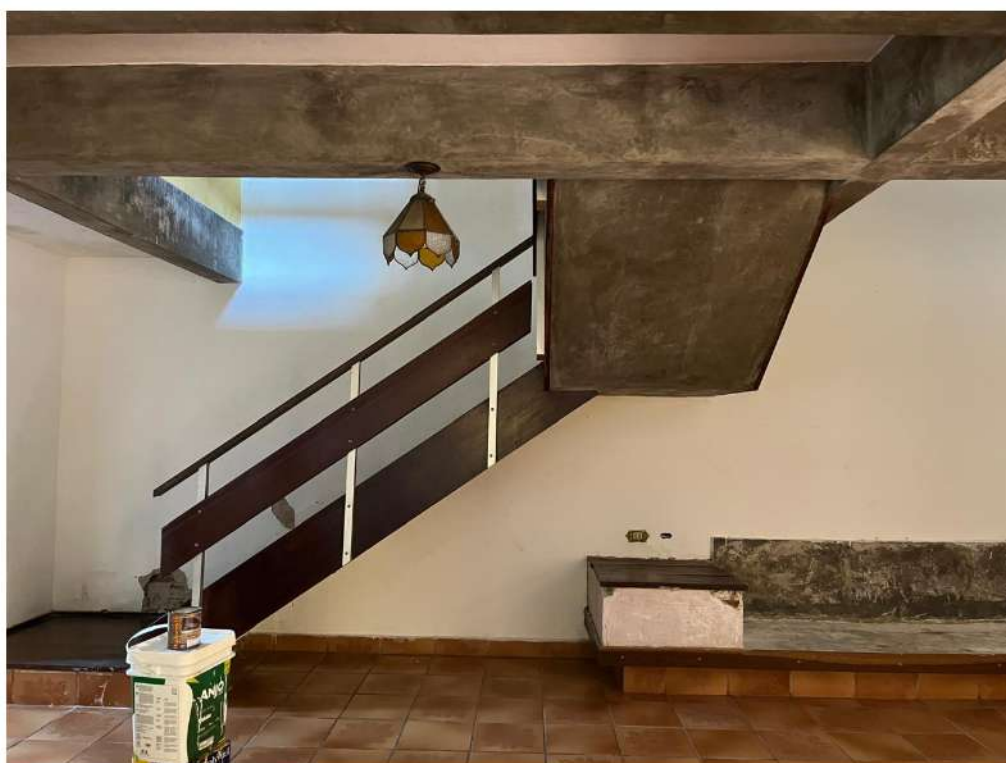
Foto nº. 15 – Outra vista da escada de acesso ao pavimento superior.
