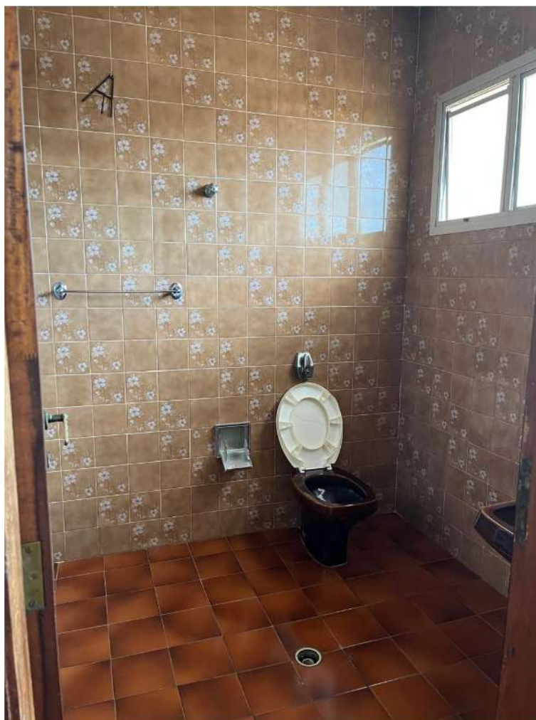
Foto nº. 35 – Vista do banheiro 2.
