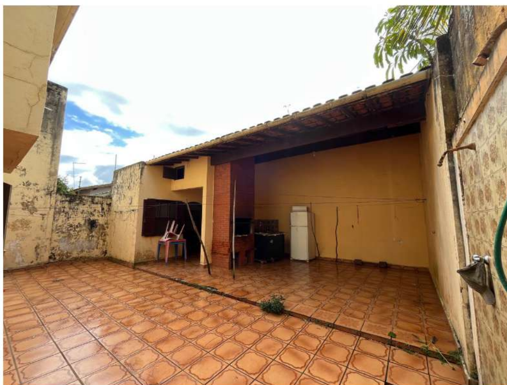
Foto nº. 19 – Vista da edícula aos fundos.
