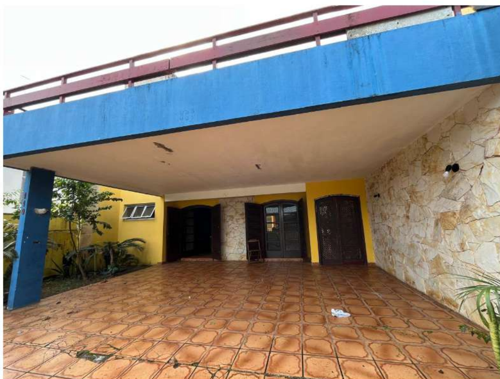
Foto nº. 4 – Vista do abrigo de autos no recuo frontal do imóvel.
