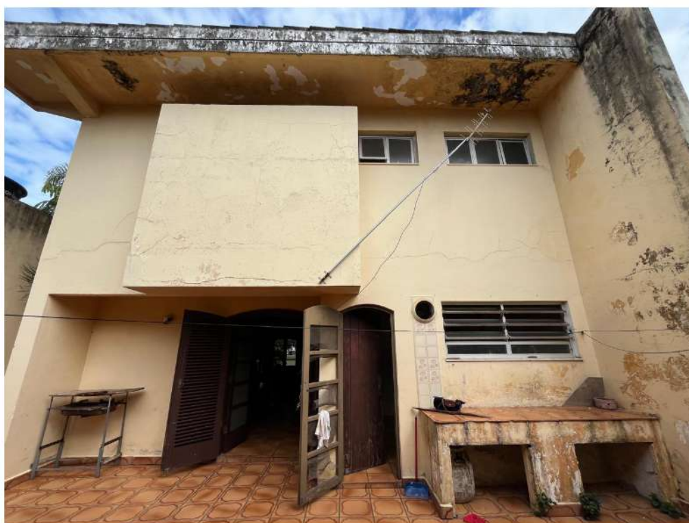
Foto nº. 8 – Vista da fachada dos fundos do imóvel.
