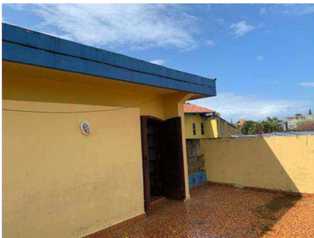
Foto nº. 28 – Vista do terraço junto ao dormitório 1.
