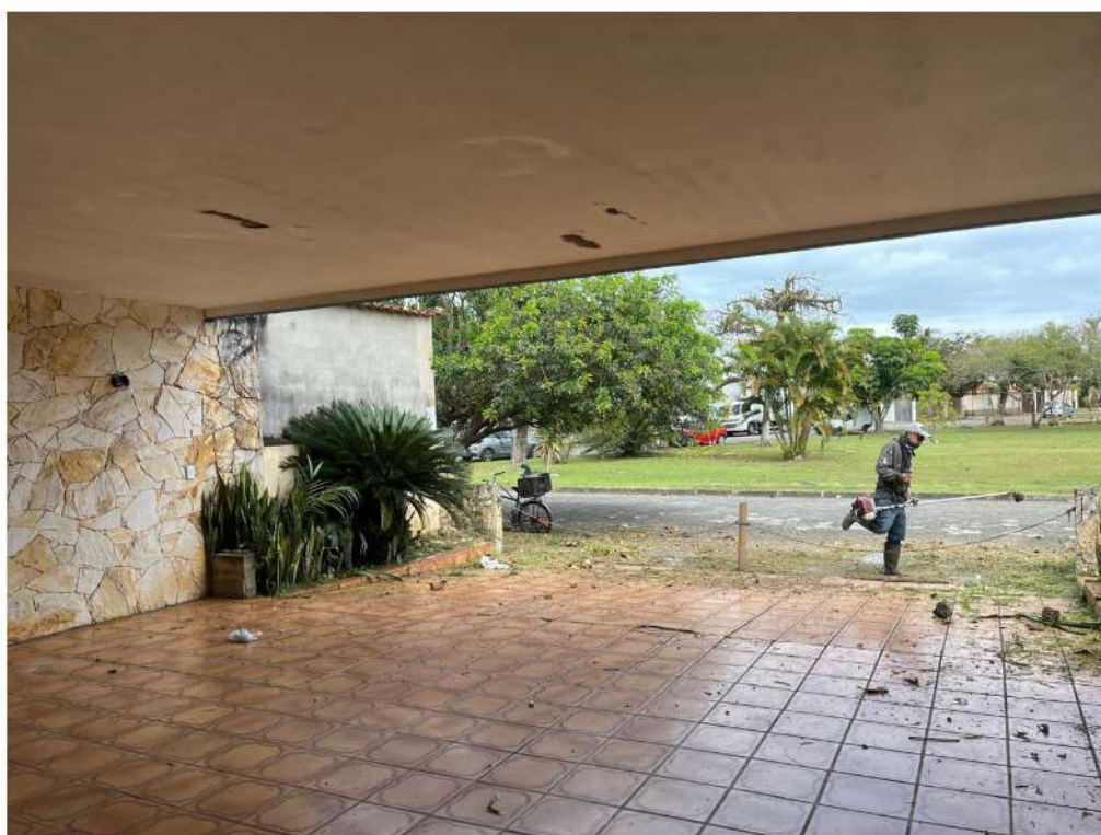
Foto nº. 5 – Outra vista do abrigo de autos.
