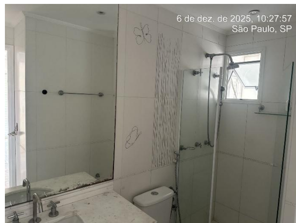
Imagem 4.1.10: Banheiro da suíte 1
